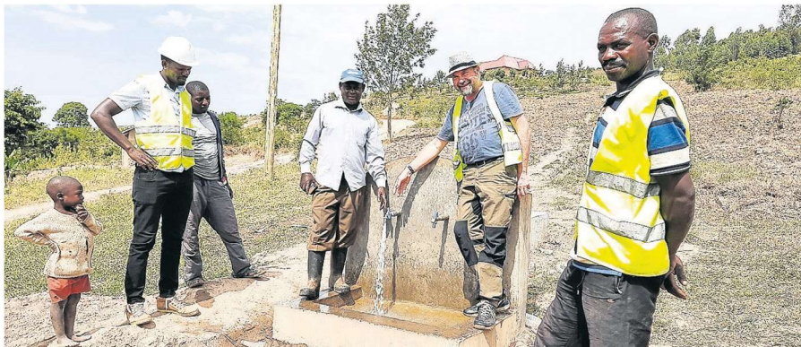
Der neue Brunnen nahe Lwamaggwa konnte Ende Mai erfolgreich in Betrieb genommen werden.
